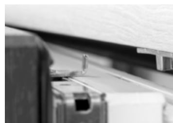
MECHANIZM STOPNIOWANEGO UCHYŁU
